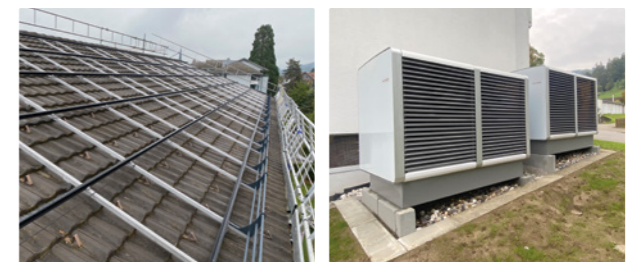
Installation von Photovoltaikanlagen und Ersatz der Gasheizung durch Luft-Wasser-Wärmepumpen.
